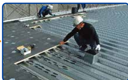
2. USボンドAによるシェンボードWの張付け
