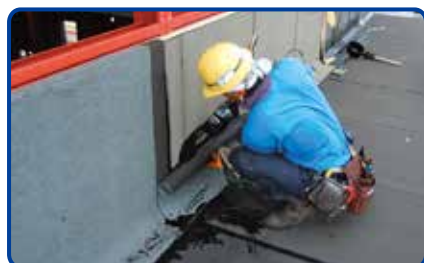
7. 防水層の施工(立上り2層目)
