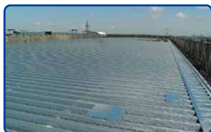
1. 波型デッキプレート敷設
