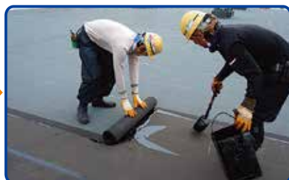
8. 防水層の施工(平場2層目)
