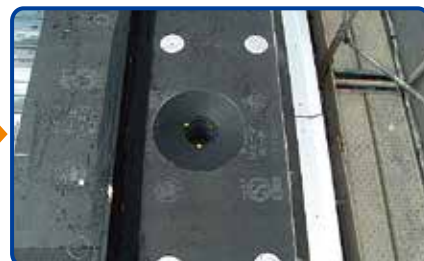
6. ドレン設置状況
