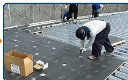
3. SDディスクIIによるシェンボードWの固定
