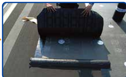
5. 防水層の施工(平場1層目)
