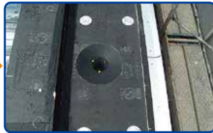
6. ドレン設置状況
