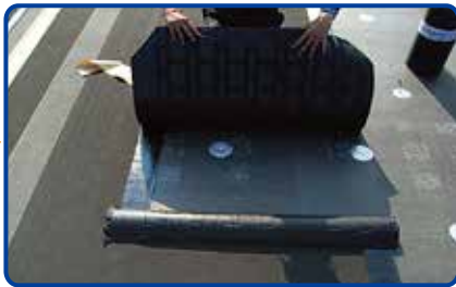
5. 防水層の施工(平場1層目)
