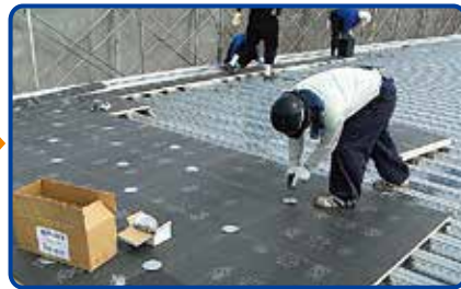
3. SDディスクⅡによるシェーンボードWの固定
