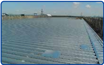
1. 波型デッキプレート敷設
