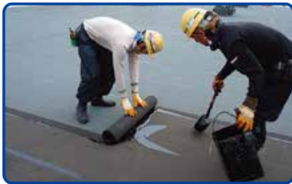
8. 防水層の施工(平場2層目)
