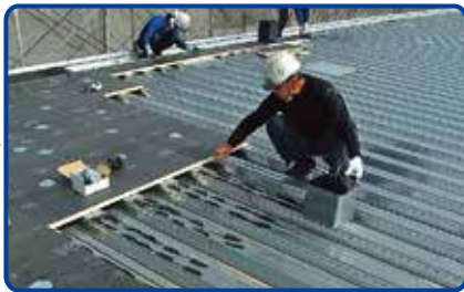
2. USボンドAによるシェーンボードWの張付け
