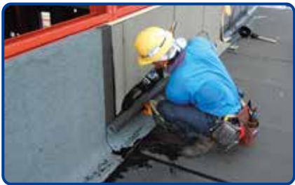
7. 防水層の施工(立上り2層目)
