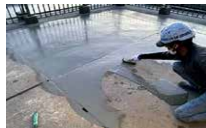
■ 下地調整及び仮防水処理
