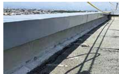
■ 下地調整及び仮防水処理
