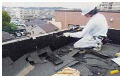
■ 既存立上り・ドレン廻り防水層撤去 (ハツリ機、ケレン棒等を用いる)
