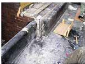
欠損部のモルタル補修
