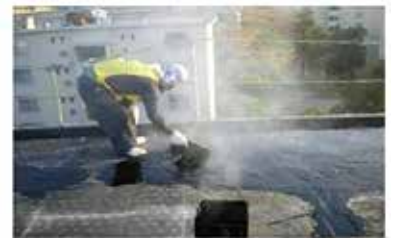
下地調整及び仮防水処理
