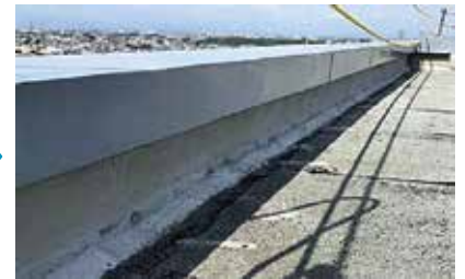
■ 下地調整及び仮防水処理
