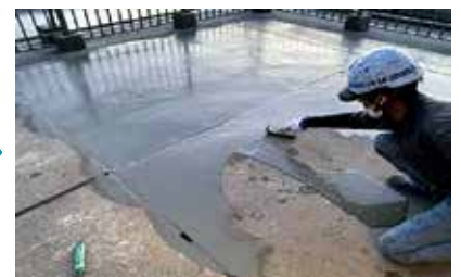
■ 下地調整及び仮防水処理
