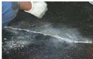
防水層撤去下地面への補修 (ひび割れ補修、剥落・欠損補修など)
