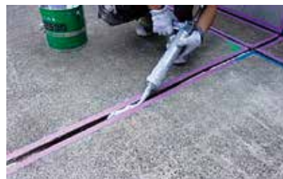
■ 下地補修及び伸縮目地処理 下地補修：ひび割れ補修、剥落・欠損補修等 目地処理：ウレタン系シーリング充填(バックアップ材共)、メジテープ等
