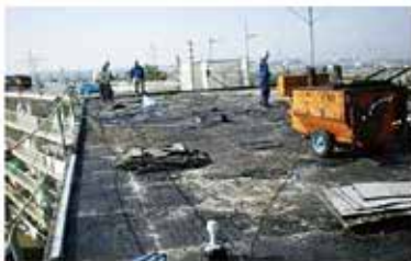
既存防水層(既存保護層共)の全撤去 (ハツリ機、ケレン棒等を用いる)
