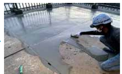
■ 下地調整及び仮防水処理
