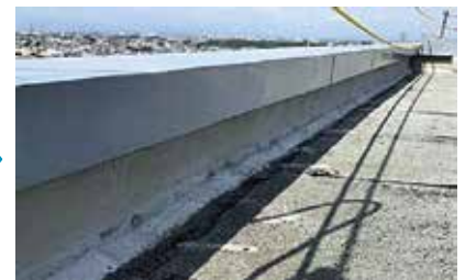
■ 下地調整及び仮防水処理
