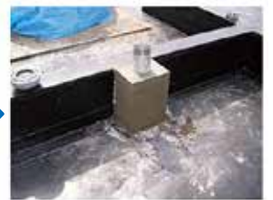
防水工事に適した形状への加工
