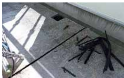
■ 既存伸縮目地材及びドレン回りの撤去 (ハツリ機、ケレン棒等を用いる)
