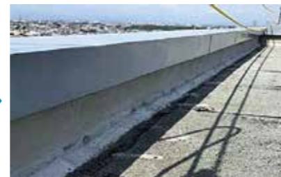
■ 下地調整及び仮防水処理
