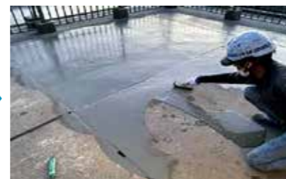
■ 下地調整及び仮防水処理
