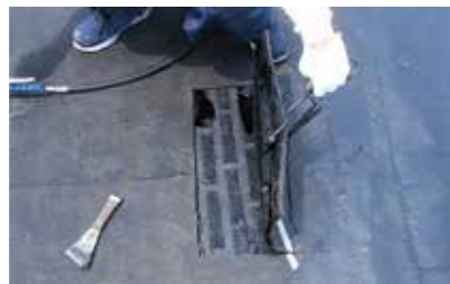
■ 下地補修 既存防水層：不具合部切開補修等 撤去下地面：ひび割れ補修、剥落・欠損補修等
