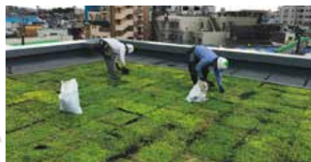
●カナートグリーンビズ穴あき 500×500×t=32mm 4.7kg ●カナート培土: 20L (14kg)/袋 カナートグリーンビズ 8枚(2m 2 分)
