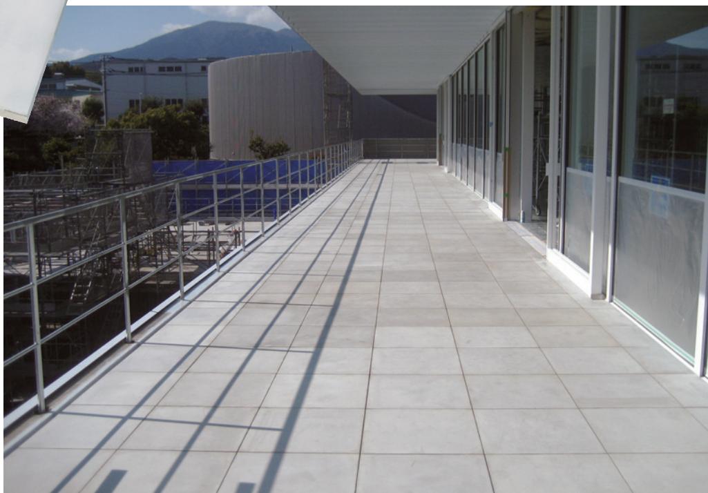
東京ウエルズテクニカルセンター
