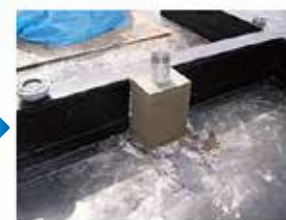
防水工事に適した形状への加工
