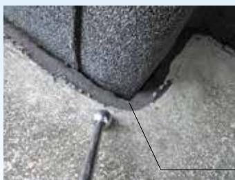
▲平場保護コンクリートと 立上り露出防水層間に 緩衝材設置
