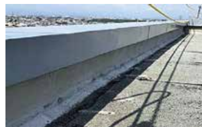
■ 下地調整及び仮防水処理
