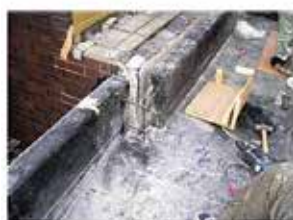
欠損部のモルタル補修
