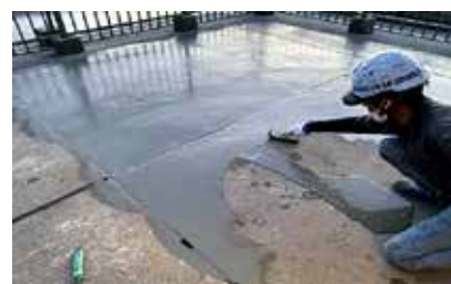
■ 下地調整及び仮防水処理
