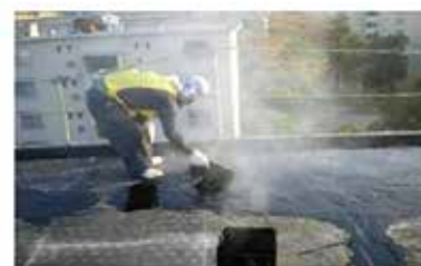
下地調整及び仮防水処理
