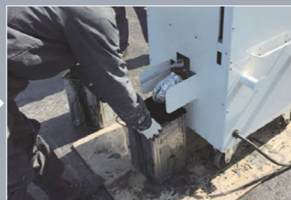
アスファルト排出
