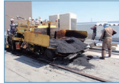
■アスファルト舗装
