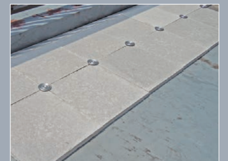
3 センター金物取り付け
