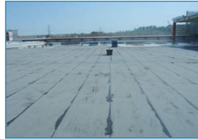
■ピロウエルドP張付け完了
