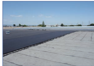
■アスファルト舗装完了
