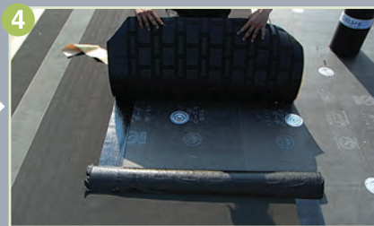
防水層の施工(平場1層目)
