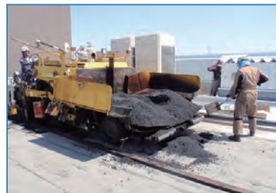
■アスファルト舗装
