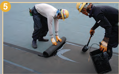
防水層の施工(平場2層目)
