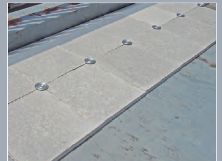
3 センター金物取り付け
