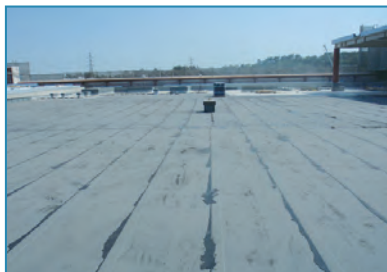
■ピロウエルドP張付け完了
