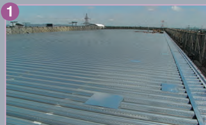
波型デッキ敷設
