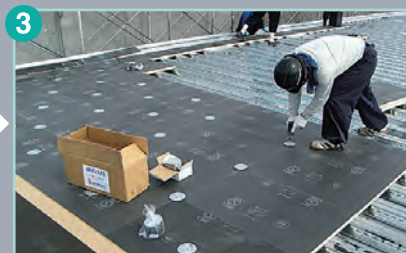
断熱材ディスク板留め
