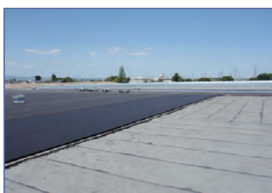
■アスファルト舗装完了
