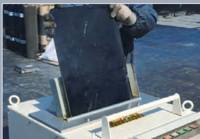
アスファルト投入
