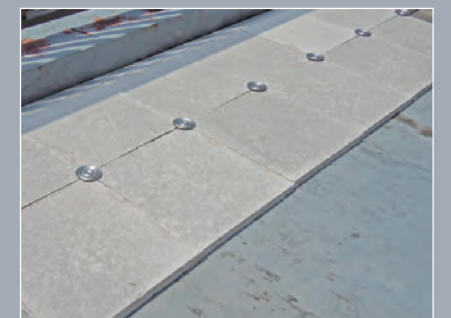
3 センター金物取り付け
