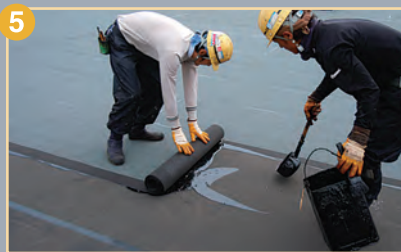
防水層の施工(平場2層目)
