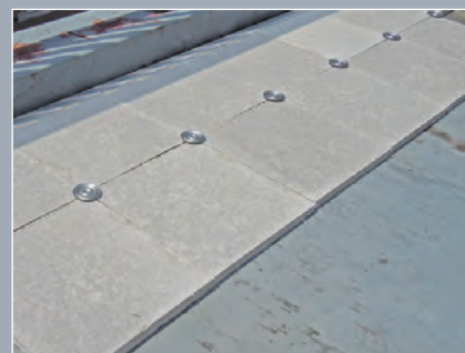
3 センター金物取り付け
