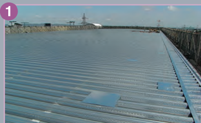
波型デッキ敷設
