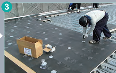
断熱材ディスク板留め
