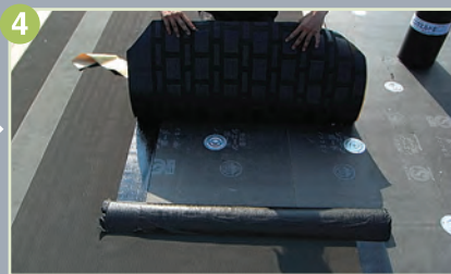
防水層の施工(平場1層目)
