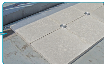
3 センター金物取り付け
