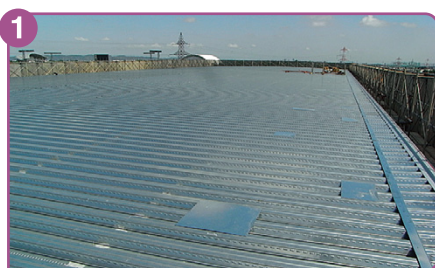
1 波型デッキ敷設
