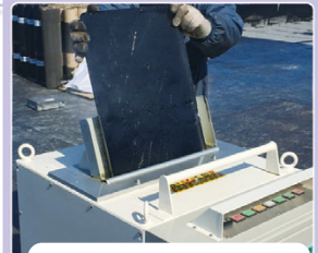
アスファルト投入
