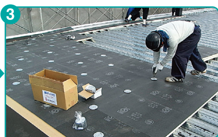
3 断熱材ディスク板留め
