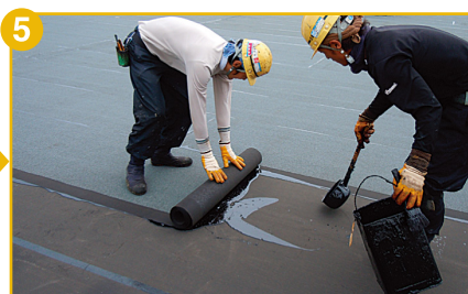
5 防水層の施工（平場2層目）
