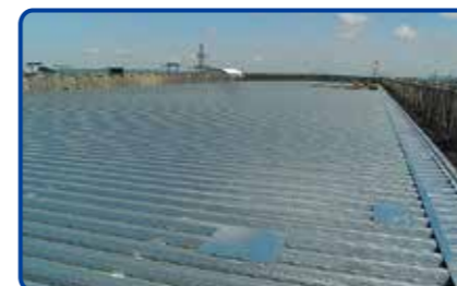
1. 波型デッキプレート敷設
