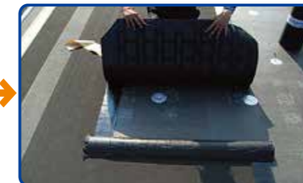
5. 防水層の施工(平場1層目)
