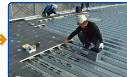
2. USボンドAによるシェーンボードWの張付け
