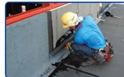
7. 防水層の施工(立上り2層目)
