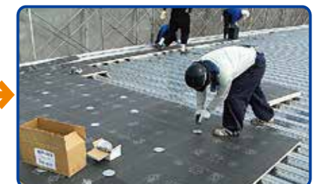
3. SDディスクIIによるシェーンボードWの固定
