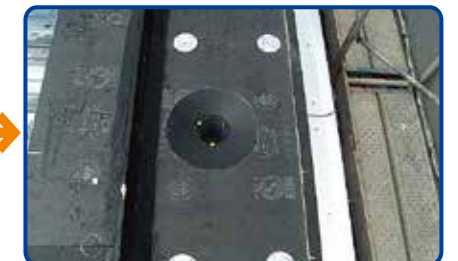
6. ドレン設置状況
