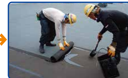
8. 防水層の施工(平場2層目)
