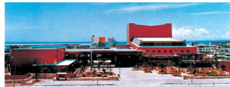
現場：石垣市民会館 設計：前川國男建築設計事務所 施工：フジタ工業・八重山興業・大山建設共同企業体 ※現場 写真は施工当時のものです。
