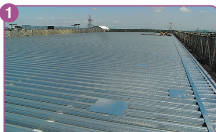
波型デッキ敷設
