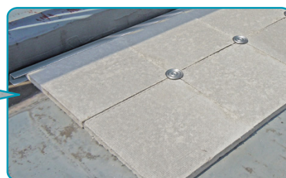
3 センター金物取り付け
