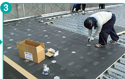
断熱材ディスク板留め
