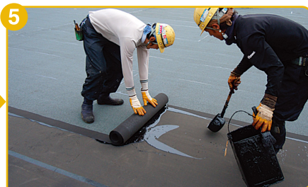
防水層の施工（平場2層目）
