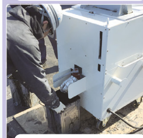
アスファルト排出
