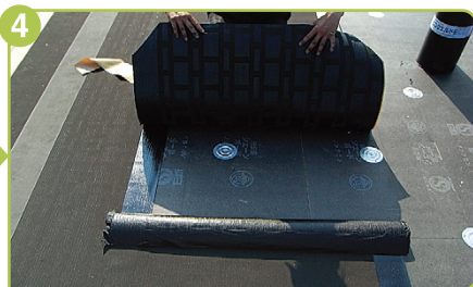
防水層の施工（平場1層目）
